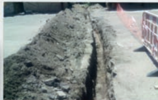
Tramo del Llano
