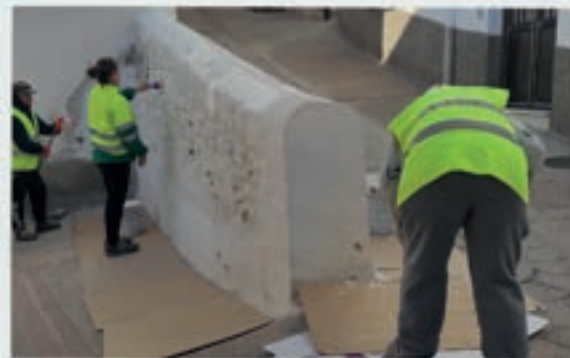
Pintura de muretes
