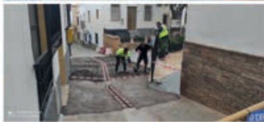
Tramo calle Horno
